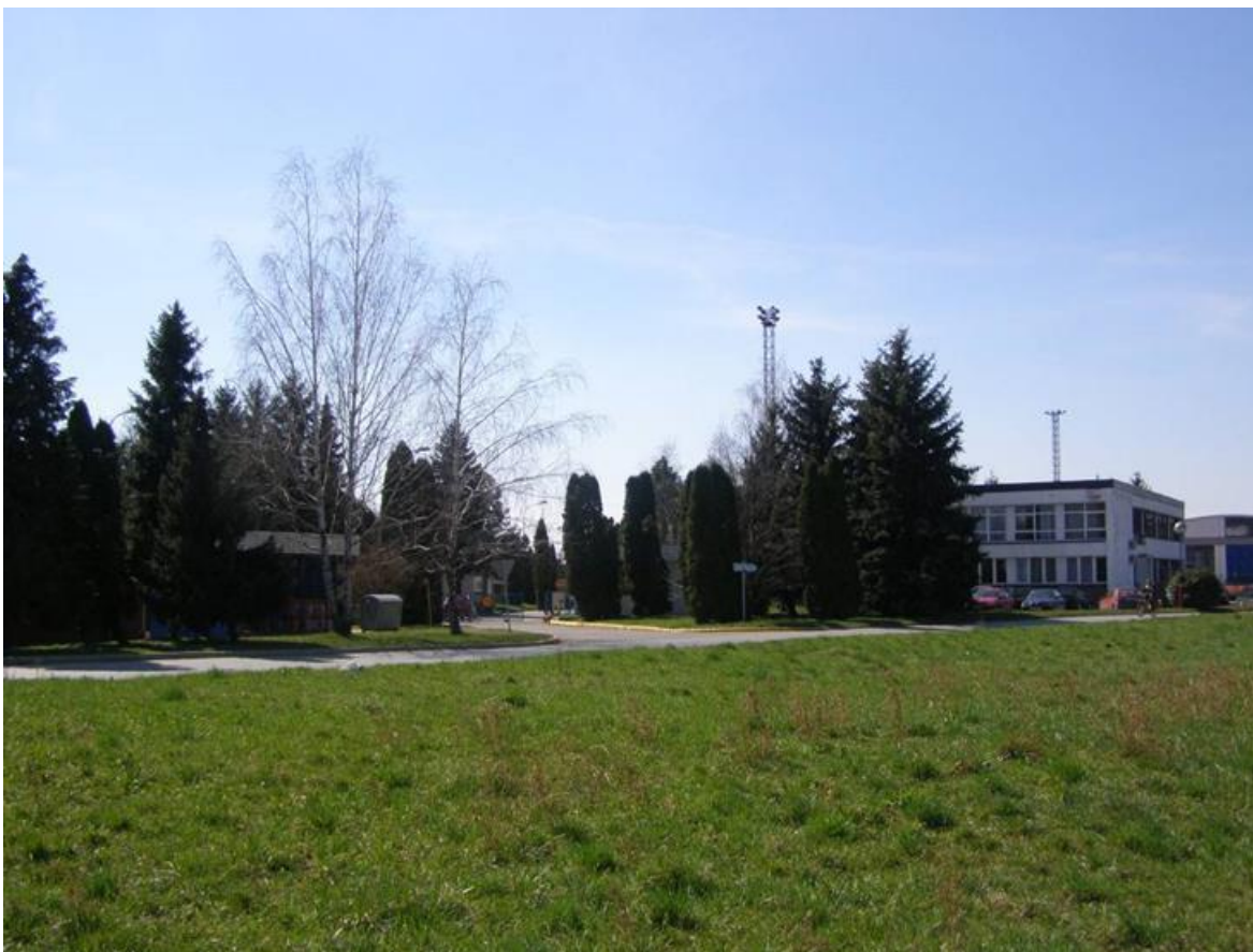
Slika 17. Uredan industrijski krug postrojenja (Foto: Krivdić/Benković)
